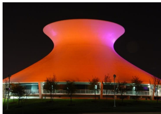
Рис. 12. Строение в форме однополостного гиперболоида
