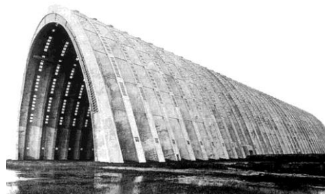
Рис. 4. Строение в форме параболического цилиндра
